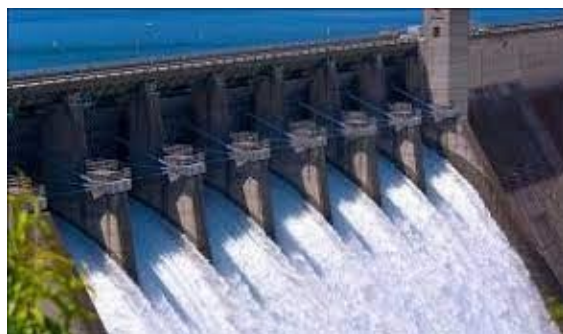
شکل ۱: نمایی از تولید برق آبی
